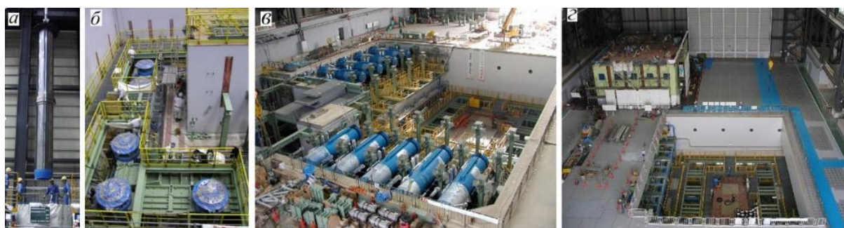
Рис. 2. Монтаж оборудования: а – монтаж гидроцилиндра; б – система вертикальных гидроцилиндров; в – система горизонтальных гидроцилиндров; г – после завершения монтажа всех гидроцилиндров
