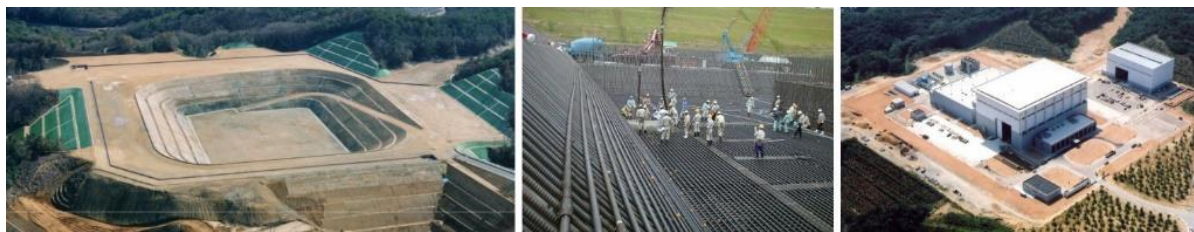
Рис. 1. Строительство лаборатории «E-Defense»
